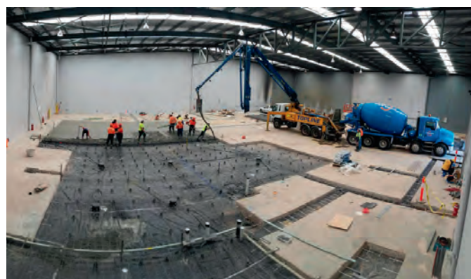
Concrete slab pour at brownfield site.
